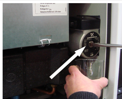
Tauscherladepumpe entlüften
