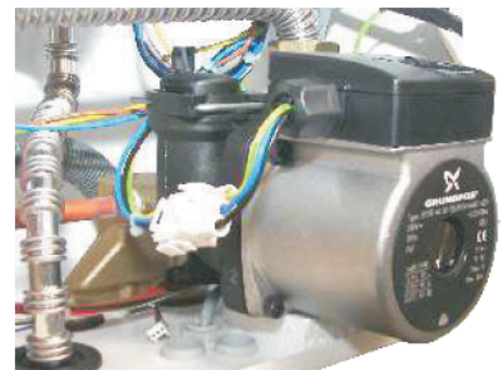
Abb. 6 Schnellentlüfter Automatisch
